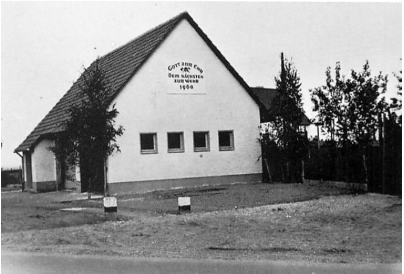
Das Feuerwehrhaus 1962 nach Fertigstellung vor der Bepflanzung. Unter dem Platz davor befindet sich der große unterirdische Löschwasserbehälter.
